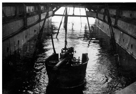
Подъем L-55. На снимке носовая часть рубки и 102-мм пушка Mk IV. 22.07 1928 г. 9 ч 15 мин.
